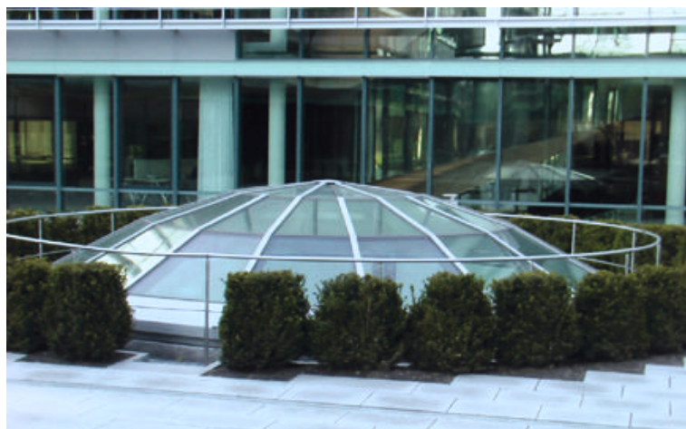
При повышенной температуре купол движется вверх: Четыре линейных привода "elero" поднимают конструкцию из стальных профилей и солнцезащитного стекла на высоту до 65 см. Фото: elero
