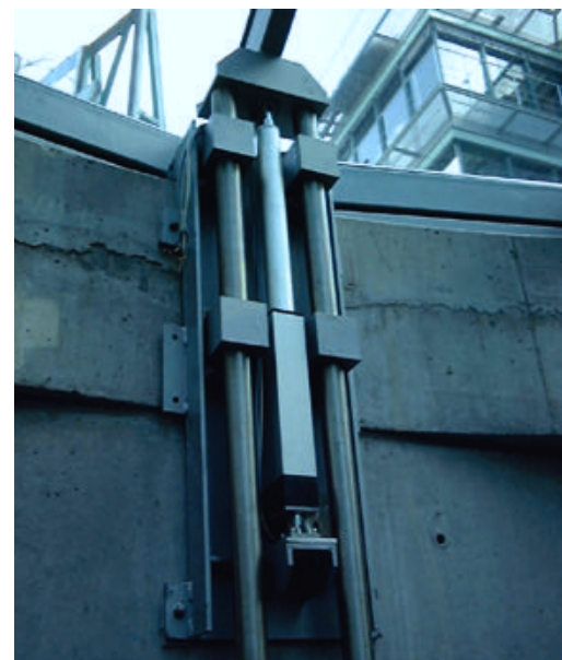
Поршневой привод "Comrakt" обладает силой толкания до 15.000 Н. Четыре таких привода могут поднять стеклянный купол весом 3,5 тонны и удерживать его в конечном положении
