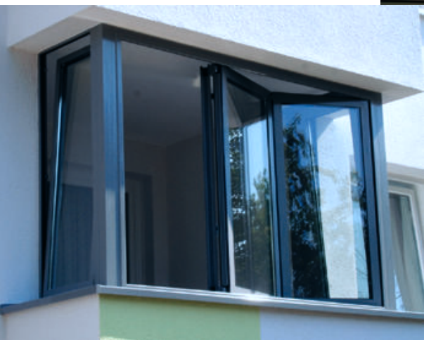
Гармошечная стена SL 60 von Solarlux легко выполняет высокие требования стандартов дома с низким потреблением энергии. Заказчика впечатлили лучшие показатели герметизации, тепло- и звукоизоляции.
