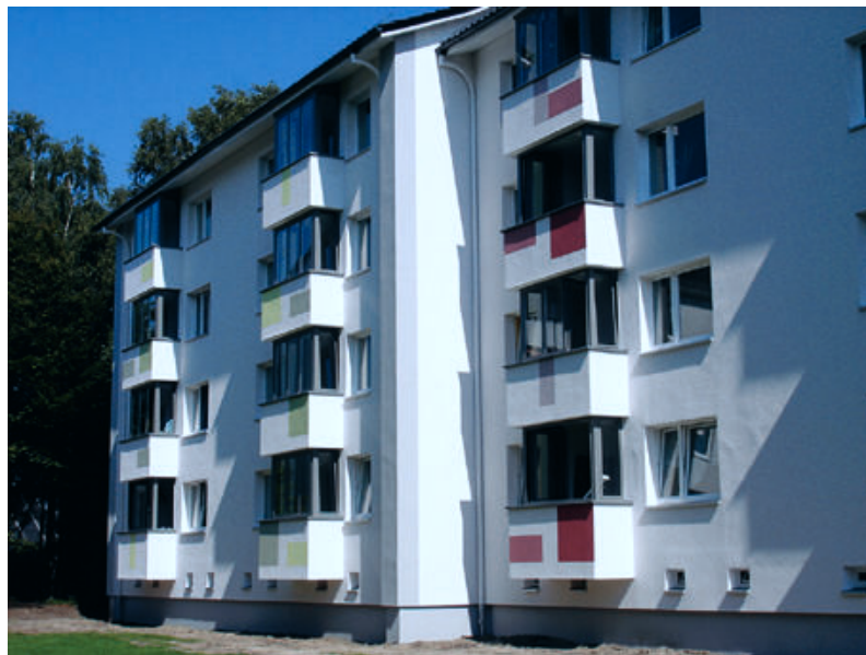
Для энергосберегающего дома в Бремене Solarlux разработал, изготовил, поставил и установил в рекордный срок 120 раздвижных гармошечных окон серии SL 60 в 24 квартирах. Фото: Solarlux Aluminium Systeme GmbH, Bissendorf
