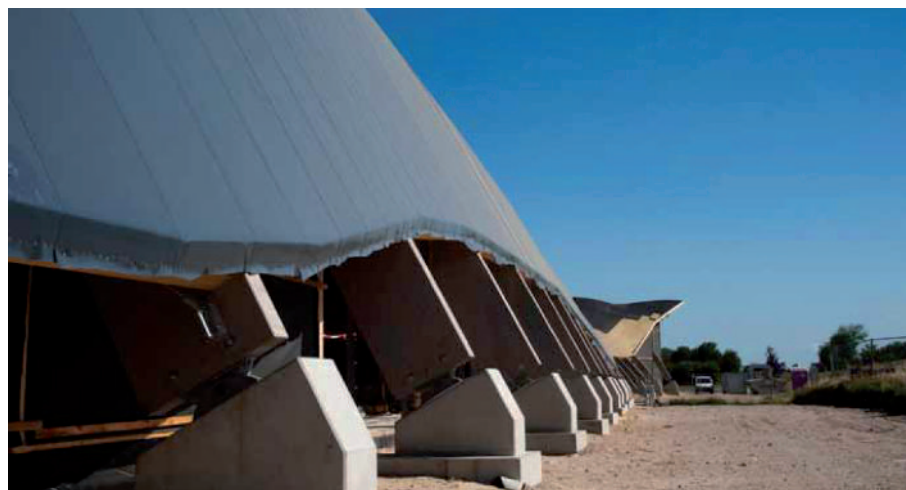
Пластиковое кровельное полотно обтягивает поверхность крыши и фасада наподобие шкуры кита, площадь 2.920 кв.м. Фото: Alwitra
