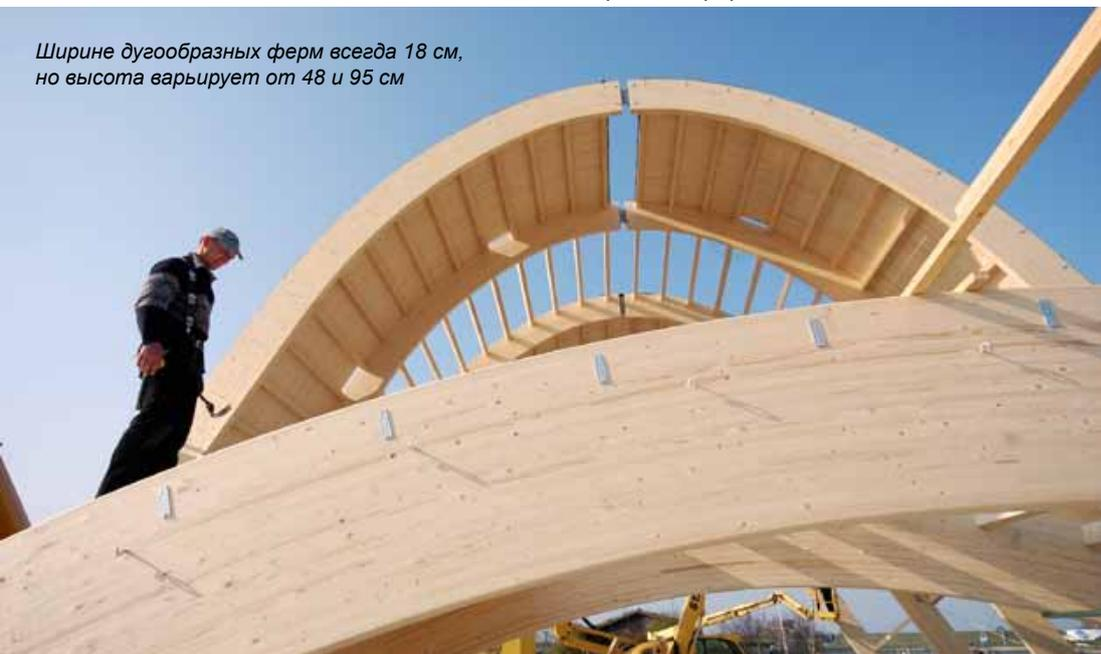
делей соединительных элементов изготовителя KNAPP® - Ricon® и Gigant.
