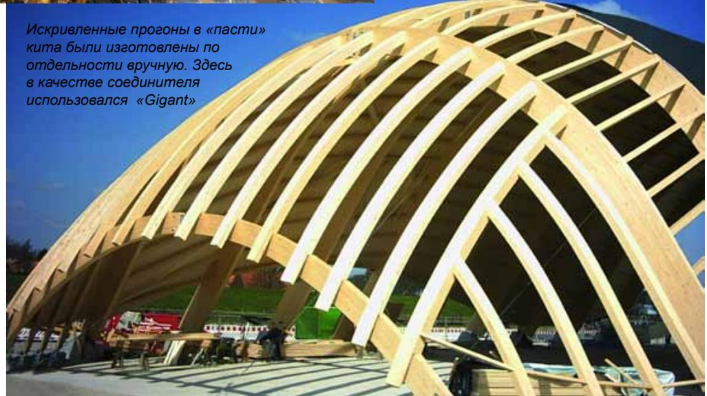
мыкали их в полную арку. Для поднятия на основаниях присоединены на шарнирах жестяные детали с прорезанными пазами. После того, как были установлены первые дугообразные фермы, можно было легко собрать и остальные детали. Несущий скелет кита полностью виден изнутри – с пожаробезопасностью здесь никаких проблем нет, поскольку стальные соединители закрыты древесиной и не при пожаре не расплавятся сразу.
