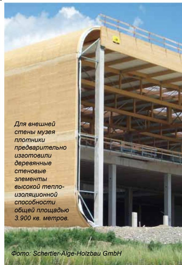
Для внешней стены музея плотники предварительно изготовили деревянные стеновые элементы высокой теплоизоляционной способности общей площадью 3.900 кв. метров.
